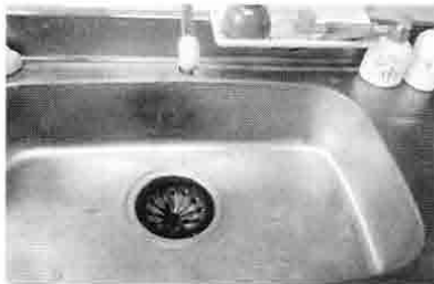
写真2: ステンレス製の流し台では、比較的割れにくい。
